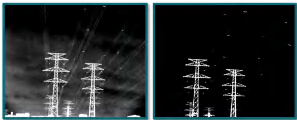
图 3.2.2-3 夜间阴雨天气下高压铁塔照片与处理过后的照片
